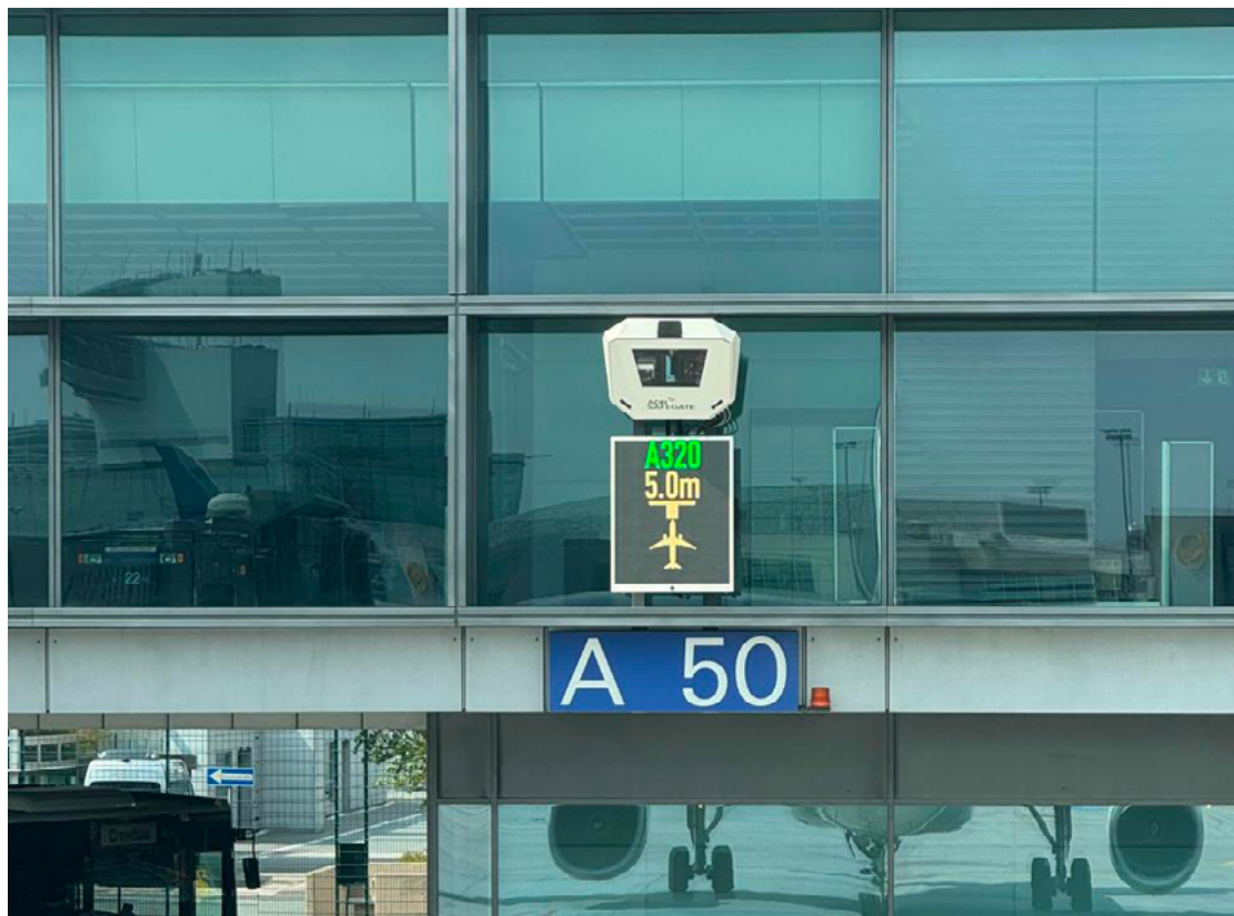
Ein Advanced Visual Docking Guidance System, kurz A-VDGS.
